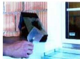
Presionar MTH ELEMENTO DE FIJACIÓN EXTERIOR JAMBA K1-PH al ras de los paneles aislantes en la sección fresada.
